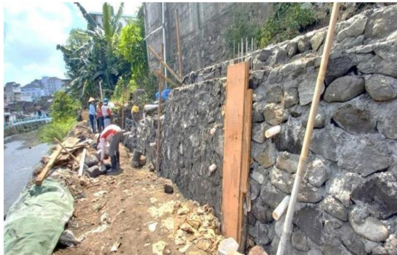
Gambar 2. Program padat karya pembangunan talud
